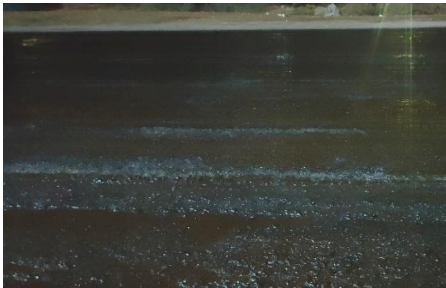
47-сурет – ЭБК-2 эмульсиясын жол жабынына жағу
