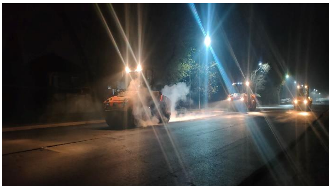
48-сурет – Резина үгіндісімен түрлендірілген тотыққан битум негізінде асфальтбетон қоспасының тәжірибелік партиясын төсеу
